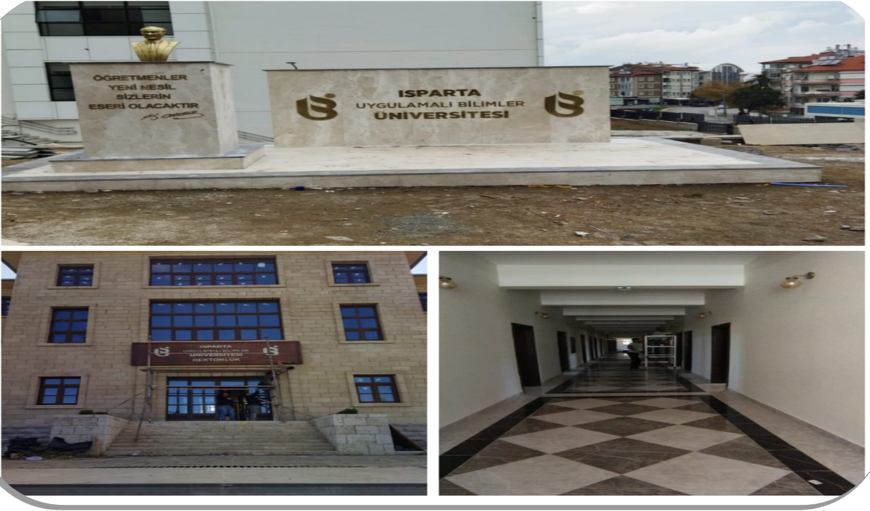
ISUBU Merkez Yüzüncü Yıl Yerleşkesi Taş Bina Restorasyonu Fotoğrafları
