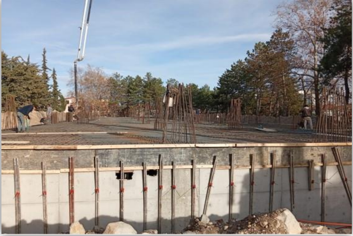
Fotoğraf 12: 100 Yıl Yerleşkesi Derslik Binası İnşaatı
