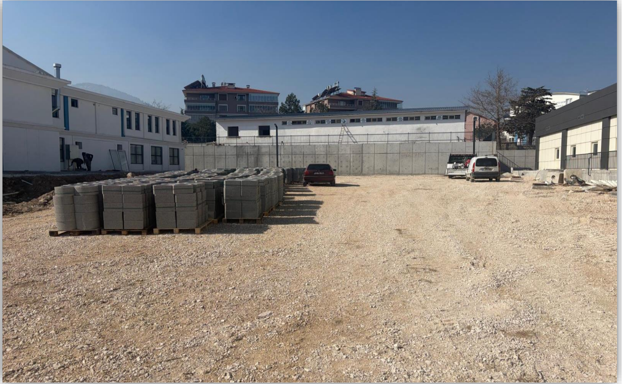
Fotoğraf 3: 100. Yıl Yerleşkesi Alt Yapı ve Çevre Düzenleme İşi
