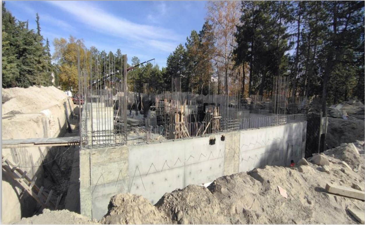
Fotoğraf 10:100 Yıl Yerleşkesi Derslik Binası İnşaatı
